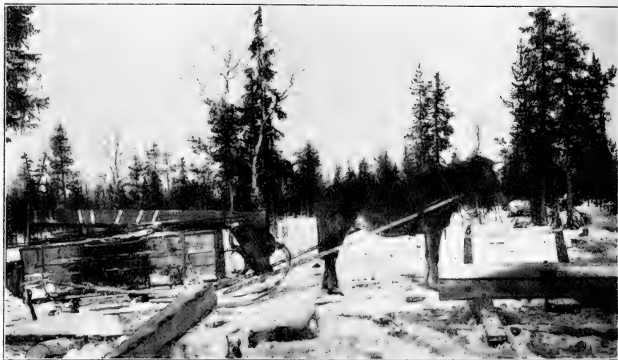
Fig. 12. Vattenlåda för vattning av basvägen.
